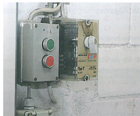
Geräteschalter müssen für ihre Funktion unbedingt beschriftet werden
