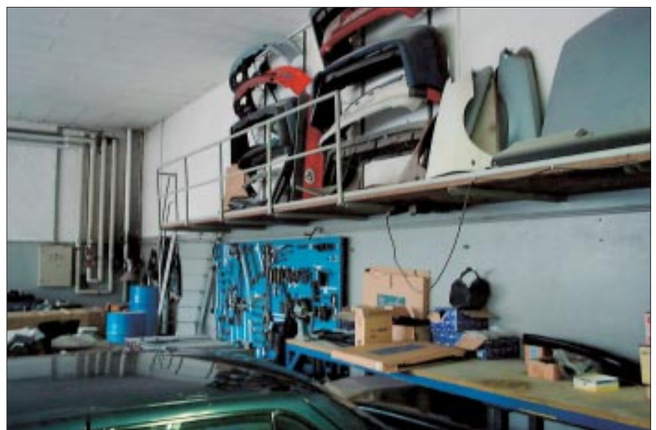
Abb. 6. Absturzgefahr durch teilweise fehlendes Geländer.
